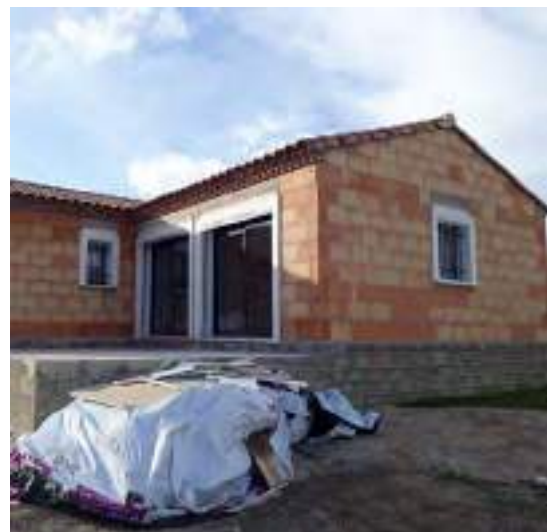
Maison individuelle en construction à Monpezat
