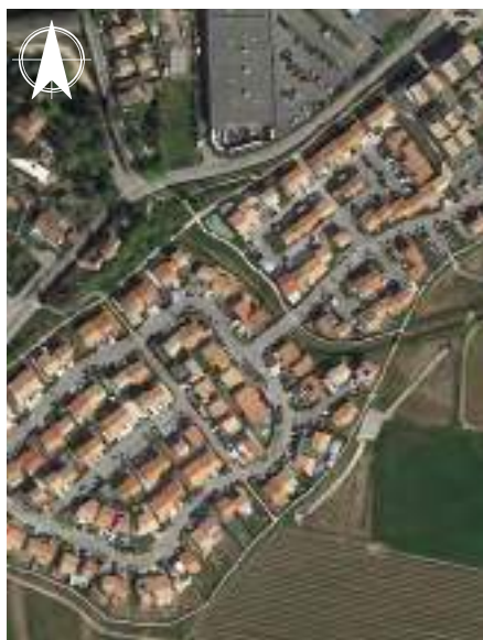
La ZAC «Les Hauts de Saint-Laze» (Sommières) : 250 logements dont 65 logements locatifs sociaux.
